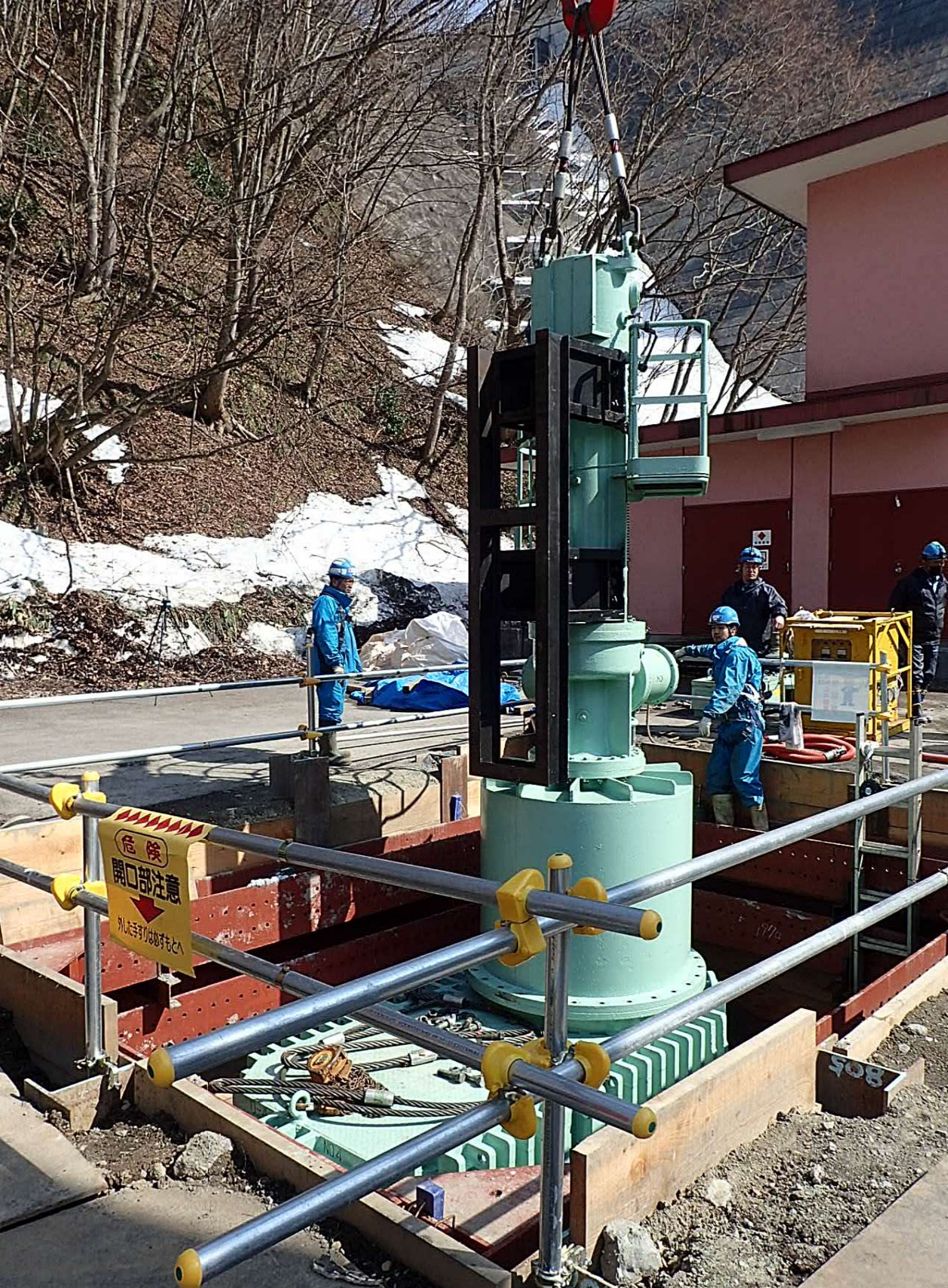
穿孔機で管を切断しています！
